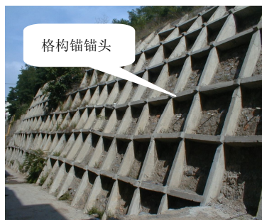
图2 格构锚边坡支护
